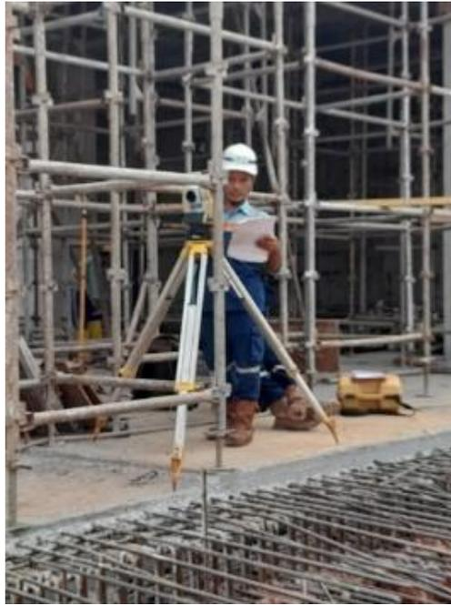
Gambar 3. Pekerjaan Pengukuran Titik Dinding Penahan Tanah
