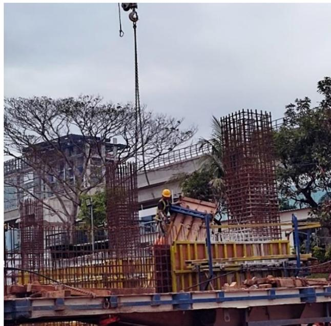
Gambar 7. Pemasangan Bekisting
