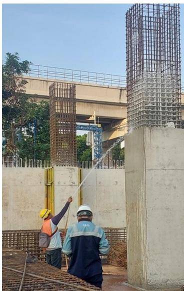
Gambar 9. Curing Beton dengan Menyiramkan Air
