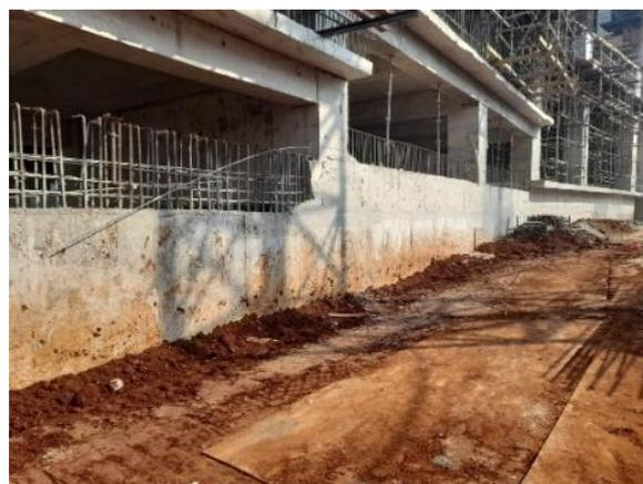
Gambar 10. Pekerjaan Urugan Tanah
