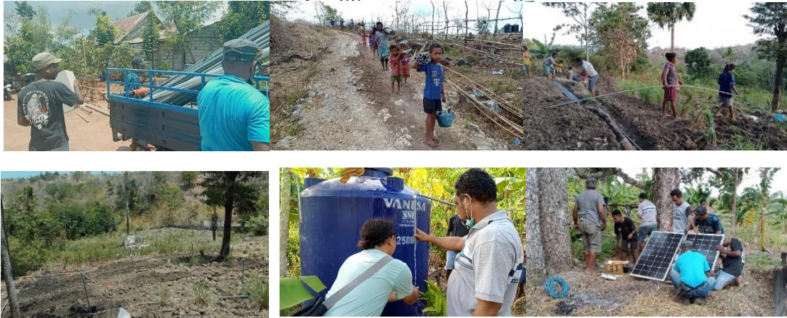
Gambar 9. Pemasangan Instalasi Pipa dan Panel Surya pada Kelompok Hidup Baru
