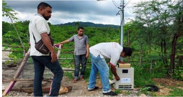
Gambar 12. Pemasangan Alat Kontrol Sistem Siram Tanaman Otomatis Hemat Energi
