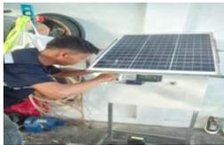
Gambar 5. Penyambungan dari Panel Surya Ke MCB
