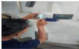
Gambar 6. Penyambungan dari MCB Ke Watt Meter
