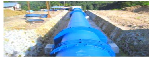
Gambar 5. Contoh konstruksi pipa pesat (penstock)
