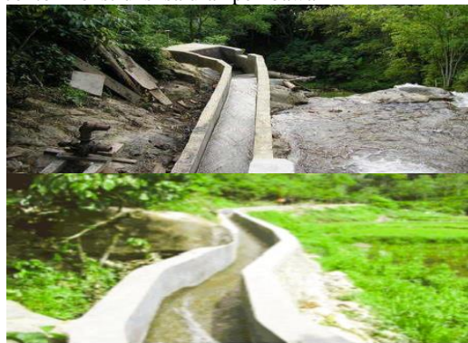
Gambar 3. - (a); (b) gambar konstruksi saluran pembawa
