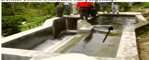
Gambar 4. Contoh konstruksi bak pengendap/penenang
