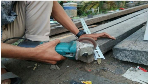
Gambar 5. Pemasangan besi siku pada box panel
