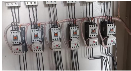
Gambar 7. Pemasangan Kontaktor dan Thermal Overload Relay (TOR)
